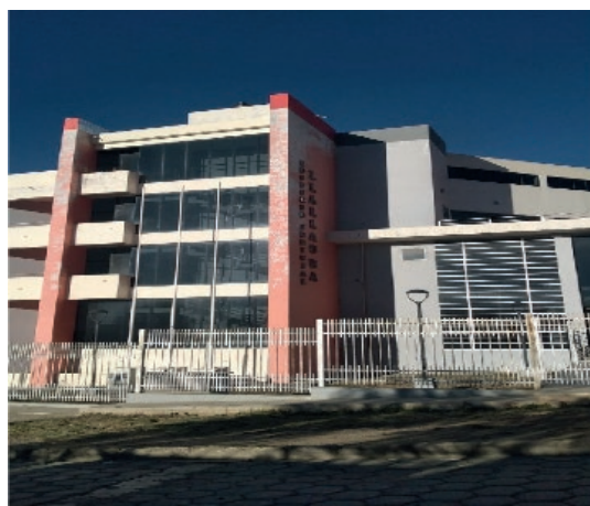
Fig. 1: Imagen del frontis del edificio del palacio de Justicia de la ciudad de Llalagua.
