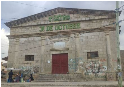
Fig. 1 Vista del edificio Teatro 31 de octubre Fuente: Elaboración propia
