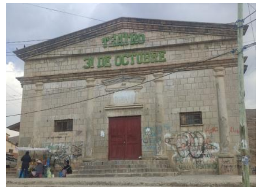
Fig. 1 Vista del edificio Teatro 31 de octubre Fuente: Elaboración propia
