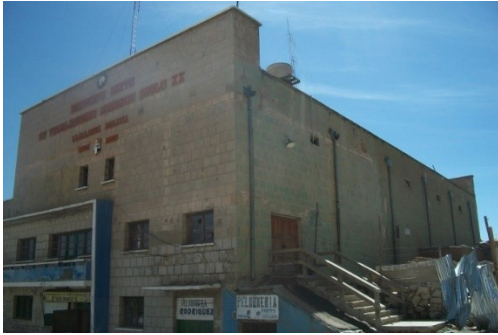
Figura 1: Vista exterior del Teatro Sindical
